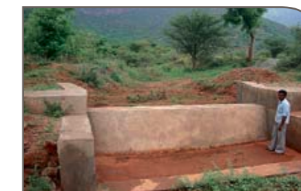
Construction d'un barrage pour l'irrigation des terres
